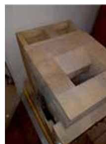
przebudowa kanałów dymowych
