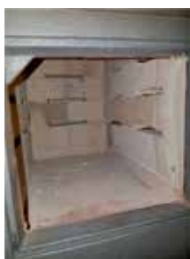
przebudowane palenisko na bezrusztowe
