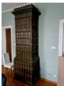
stary piec węglowy przed przebudową
