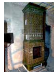
piec na drewno piecokominiek po przebudowie
