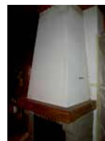
ściana obudowy z płyt akumulacyjno- grzewczych
