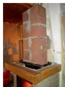
dobudowane akumulacyjne kanały piecowe
